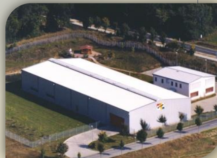
Verwaltungs- und Logistikzentrum der gewe LagerTec
