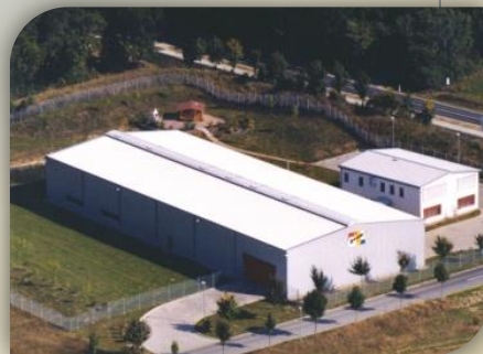
Verwaltungs- und Logistikzentrum der gewe LagerTec
